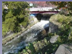
猿投橋 ・落差あり
