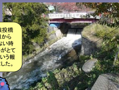
猿投橋の落差
