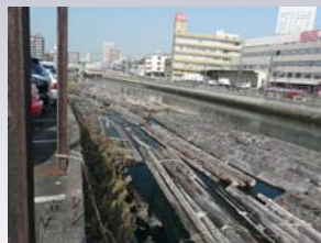
山王橋～瓶屋橋間 ・材木が浮かんでいる
