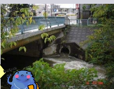
木津根橋下流側の左岸雨水吐からの濁水
