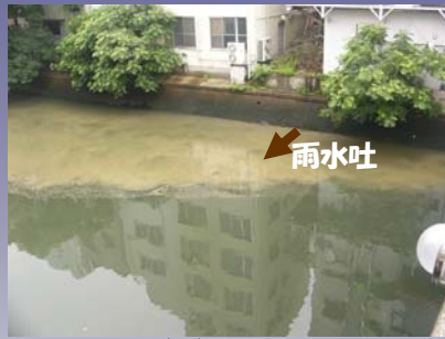
2007/7/26 11時20分 雨天時における下水道雨水吐からの放流状況 名古屋地方気象台: 5.0mm/時間 (5.5mm/日)
