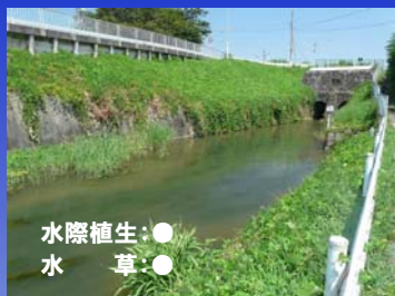
元杵樋門下流
