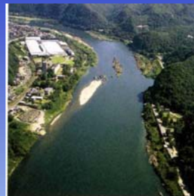
木曽川・犬山取水口付近の様子
