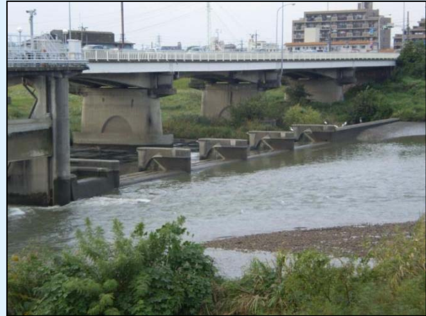
(右岸側) 転倒ゲート×4基
