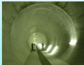
堀川右岸雨水滞水池
