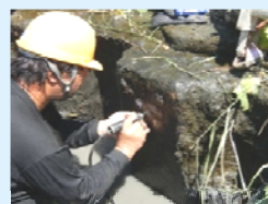
矢板の肉厚測定状況
