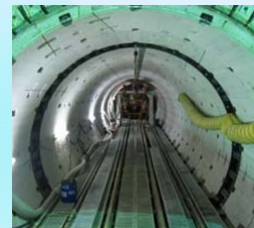
堀川左岸雨水滞水池
