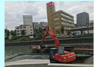
河床掘削の様子
