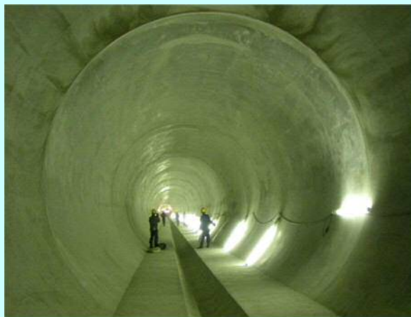
堀川右岸雨水滞水池
