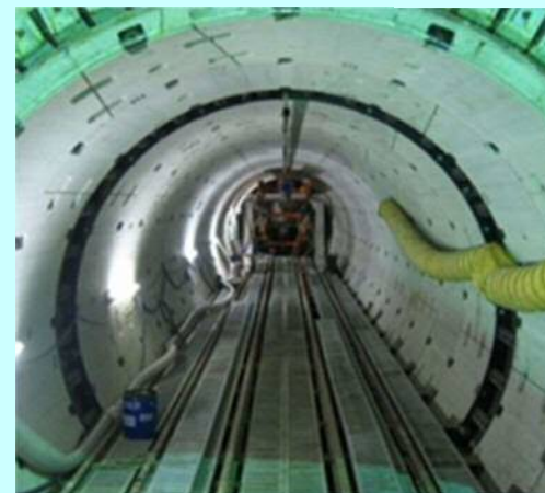
堀川左岸雨水滞水池
