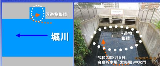
御陵橋・瓶屋橋・住吉橋などの橋台の凸部に集積する浮遊物
