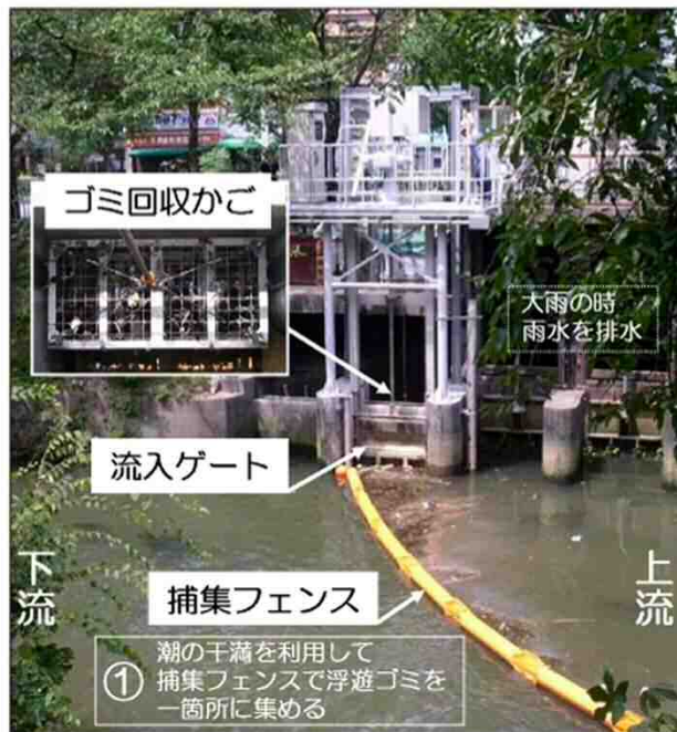
施設の設置状況
