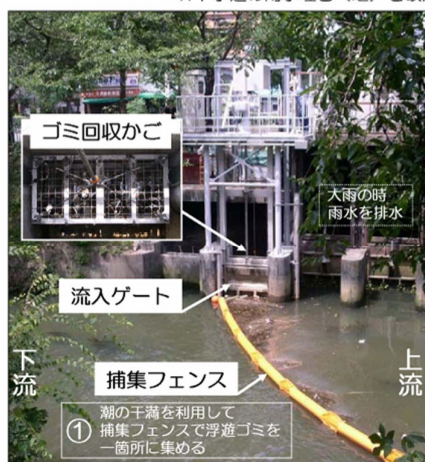
施設の設置状況
