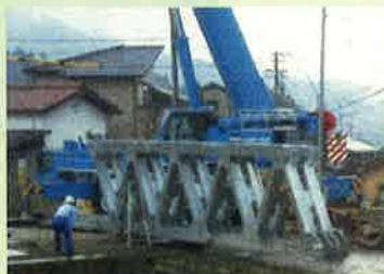
仮設橋 設置状況
