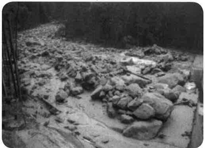
土砂捕捉状況（梨子沢第2砂防えん堤）
