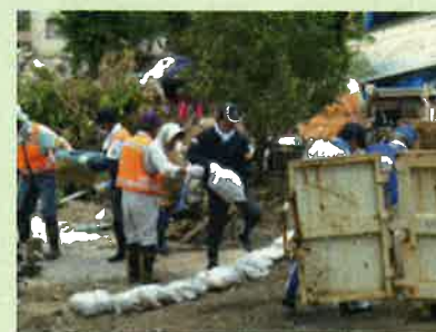
土砂の除去作業の様子
