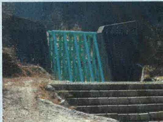
梨子沢第1砂防えん堤
