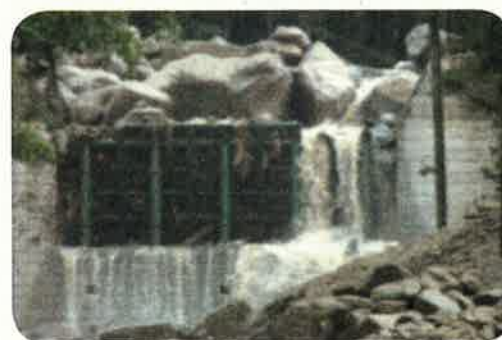
巨石の捕捉状況
