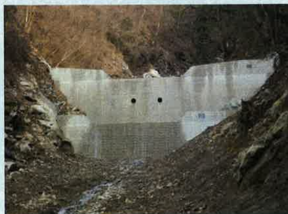
小梨子沢 治山谷止工
