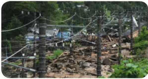
J R 中央線への土砂の流入
