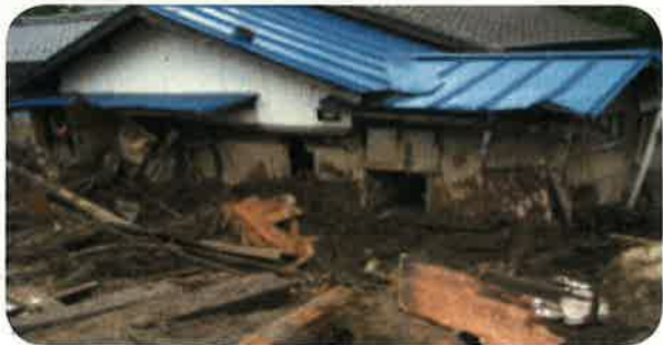
家屋への土砂流入
