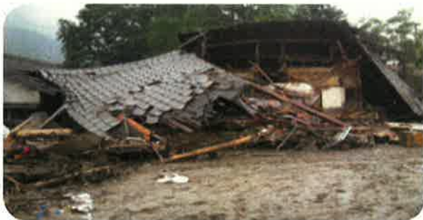
土砂流入による家屋の全壊
