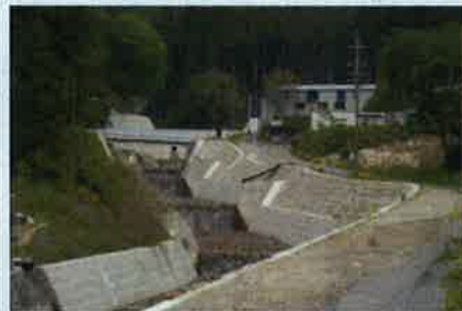
梨子沢線と細野洞橋
