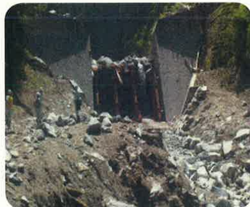
土石を捕捉したえん堤
