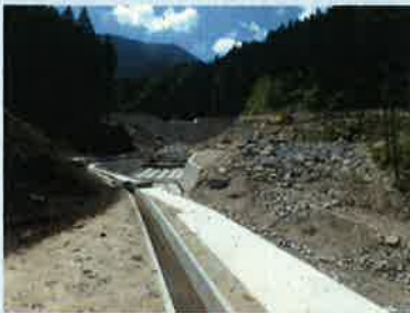
梨子沢農業用水路頭首工
