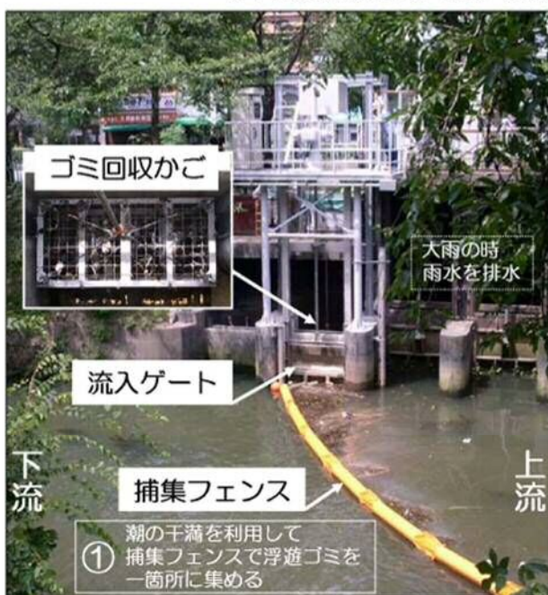
施設の設置状況
