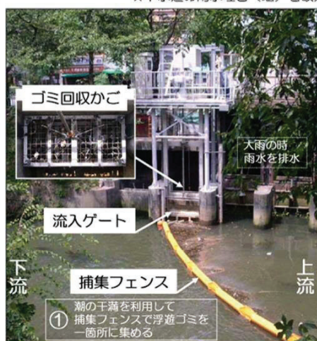
施設の設置状況
