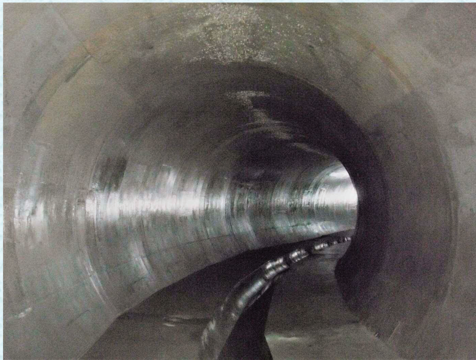
堀川左岸雨水滞水池
